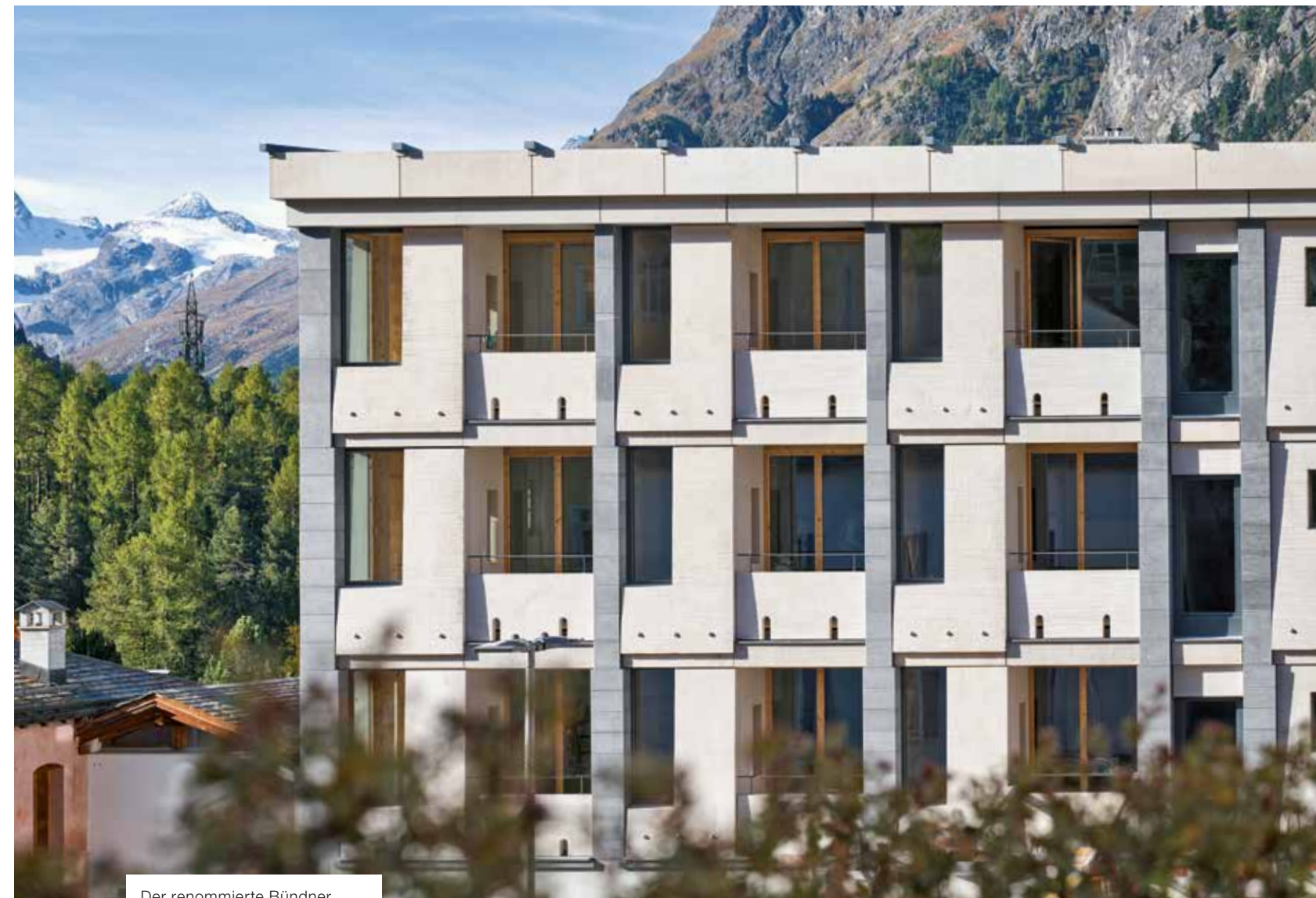
Der renommierte Bündner Architekt Gion Caminada hat dem Hotel einen neuen Anstrich gegeben.
